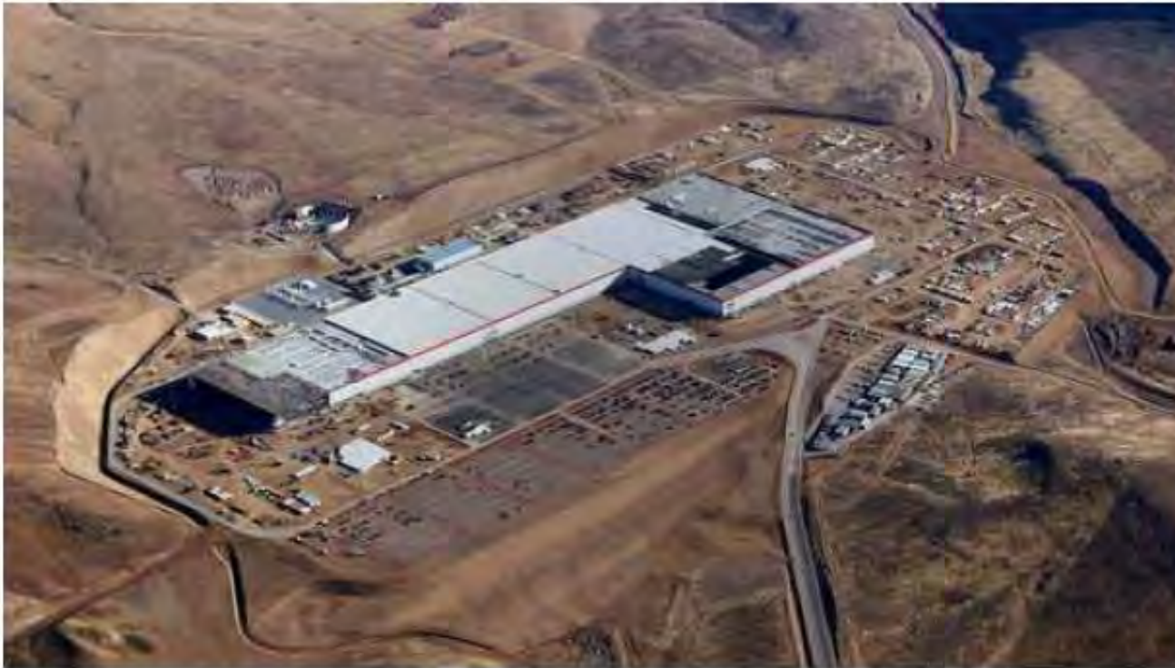
L'usine Tesla « Gigafactory » en janvier 2017 TESLA
